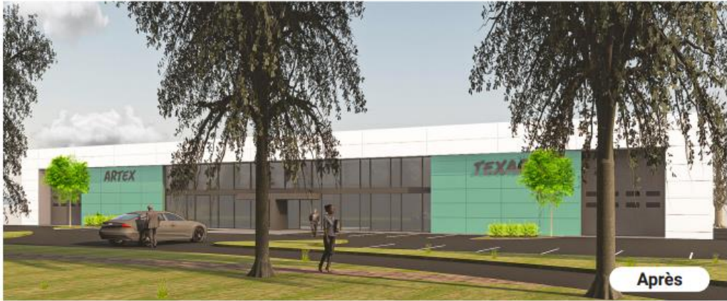
Réhabilitation d'un bâtiment industriel à Cergy St Christophe
